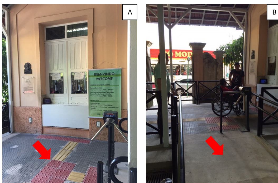
Figura40 - A)Piso direcional para deficientes visuais; B) rampa com largura e declividade para maior acessibilidade
